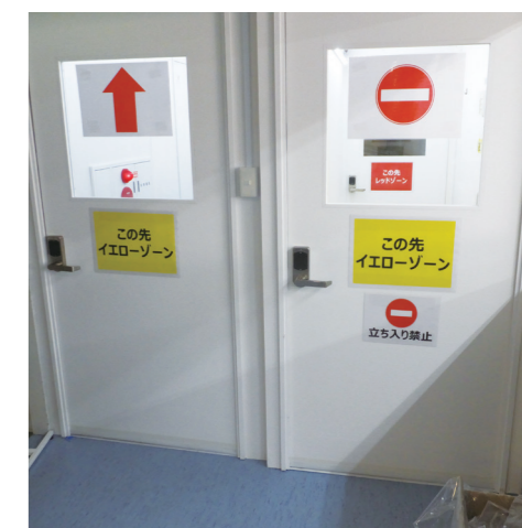
高齢者等医療支援型施設のイエローゾーン入口。出入りする人が交わらないように、間仕切りが設置されていた。
