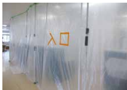
ICU/ステーション間仕切り
